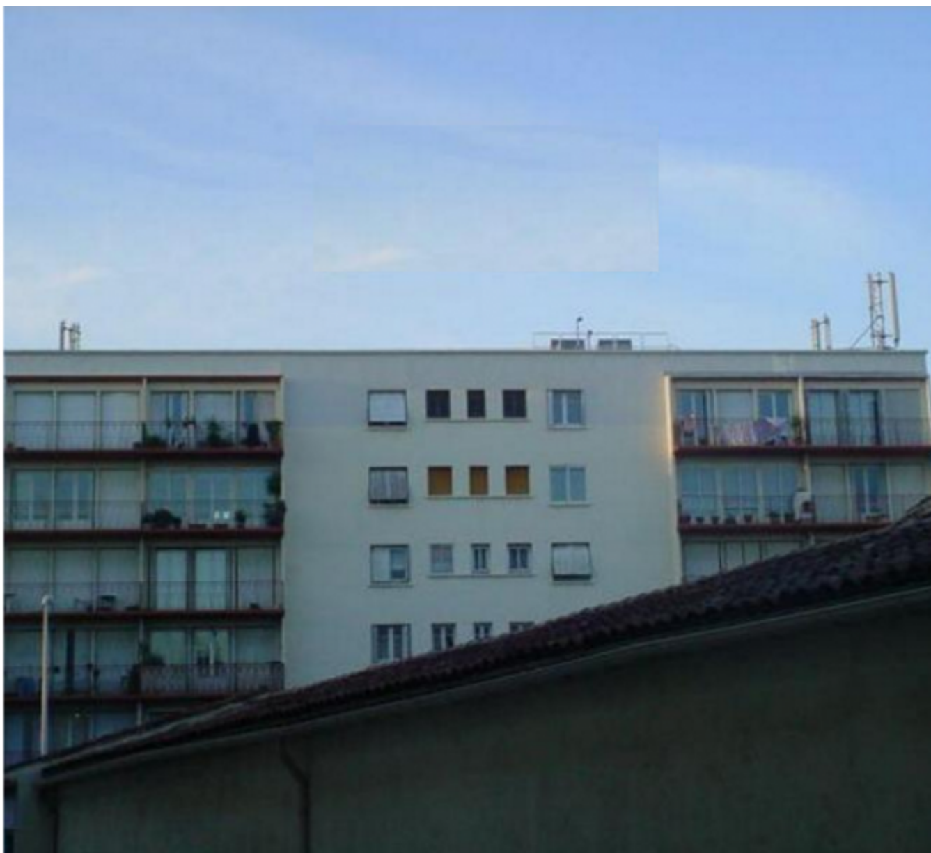
vue 1 : Photo depuis la rue Marcel Arnoye. Pas de modification anetnnaire.
